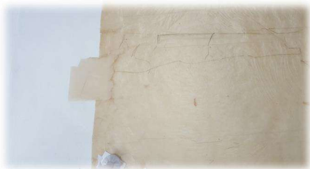
Imagen 10: reintegración de faltantes
